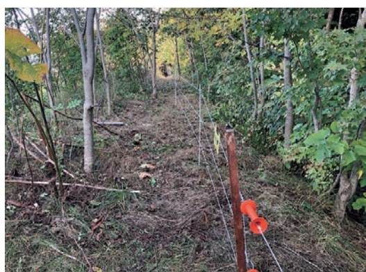
■図6. 電気柵の設置状況
