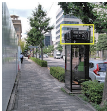
■図4. 電話ボックスへの設備設置の一例
