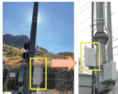
■図6. 付帯設備（電源設備）小型化の一例
