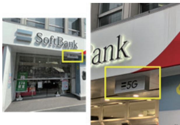
■図2. 看板を模したアンテナの一例
