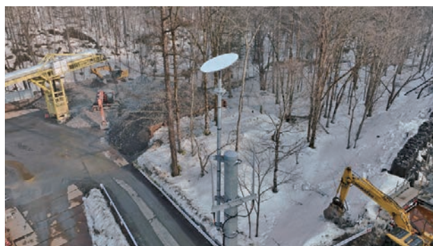
■図7. 北海道新幹線、渡島トンネル（上二股）工区（JR TT発注）工事現場のSML利用
