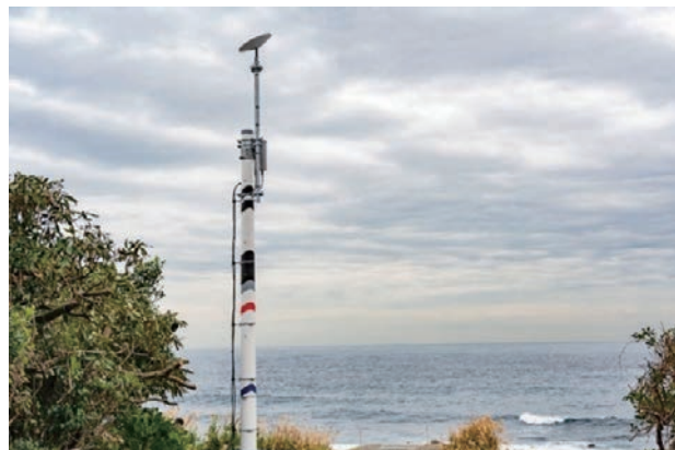
■図3. 初島のStarlinkを用いたau基地局
