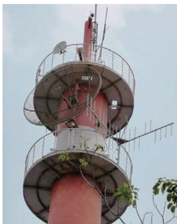
■ 図3. 高い赤白鉄塔上部に設置されたノンタブリ・キャンパス向けのUHFアンテナ (2020年2月ナロン先生撮影)
