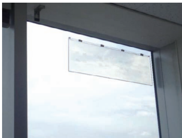
■図2. 建物用ガラスアンテナ（※ケーブル接続なしの状態）
