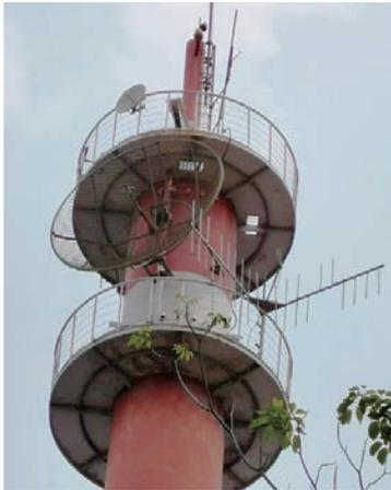
■ 図3. 高い赤白鉄塔上部に設置されたノンタブリ・キャンパス向けのUHFアンテナ (2020年2月ナロン先生撮影)
