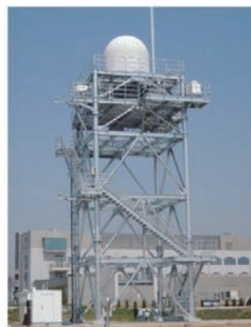
(a) 全体の外観
