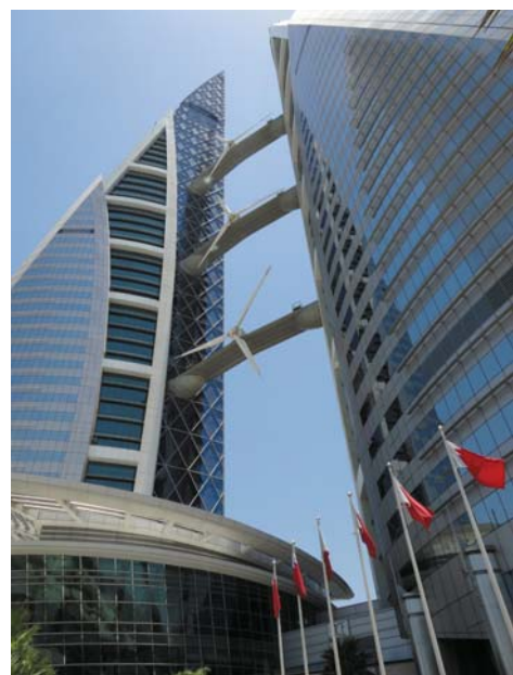
写真5. バーレーン世界貿易センター。高さ240m、南北のメインタワーの間に3基の風力発電用風車を取り付けられている。
