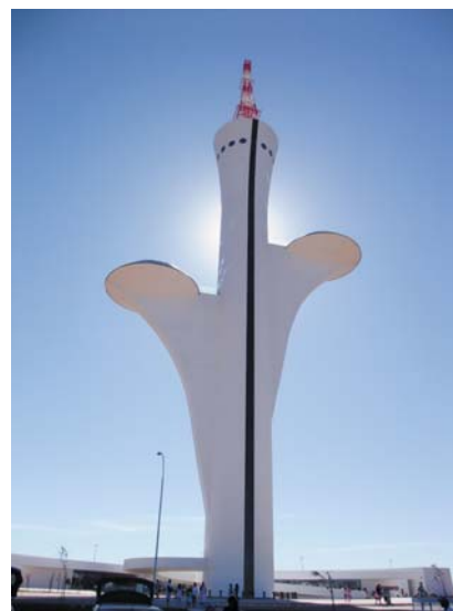
写真2. “一応”完成したブラジリアのデジタルテレビ塔。中身はまだないですが、市民には好評です
