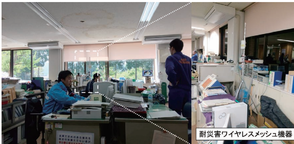
■図6. 高森町役場におけるネットワーク提供（1階執務室）
