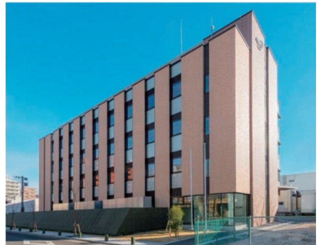
■ 図1. 耐災害ICT研究センター外観
