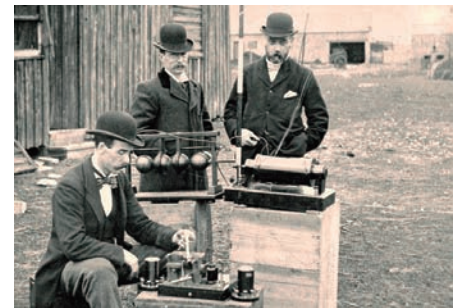
写真1. フラットホルム島 (Flat Holm Island) における実験デモの最中、マルコーニの無線電信機を調べる英国郵便公社の技術者 (出典：Cardiff Council Flat Holm Project via Wikimedia Commons)
