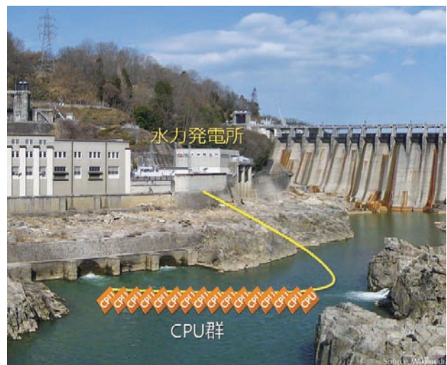
■図1. 川にコンピュータを沈めて冷やす
