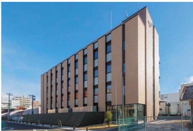
図1. 耐災害ICT研究センター研究庁舎外観
