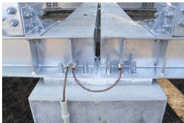
写真4. エクスパンションジョイントを設けた基礎・架台
