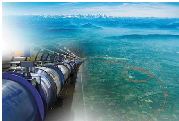
図2. 大型ハドロン衝突型加速器（LHC）は全周27kmに及び、超伝導電磁石からの高エネルギーで素粒子を衝突させるため幾つもの加速器で構成されている。
