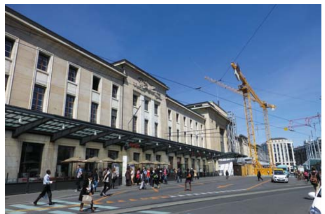
図6. 北側半分が工事中のコルナヴァン駅
