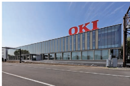
■ 図1. 建物外観写真
