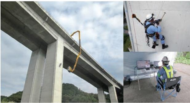
■ 図4. ロープアクセスが必要な橋梁点検の現場（写真）
