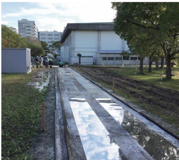
(a) 鉄板レール埋設工程 (この上をアスファルトで全面舗装する)
