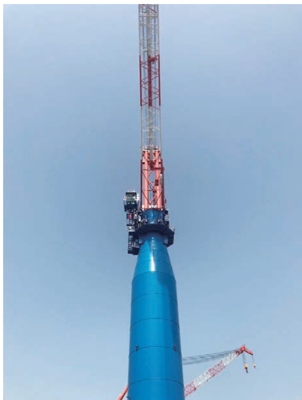
■写真4. ジブクレーン
