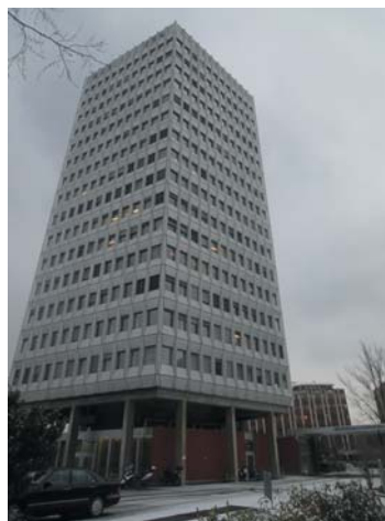
Photo 3-3. ITUタワービル
