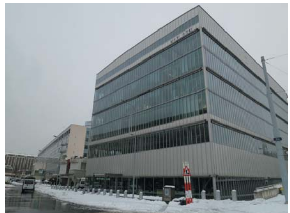
Photo 4-1. ITU Montbrillant（モンブリアン）ビル
